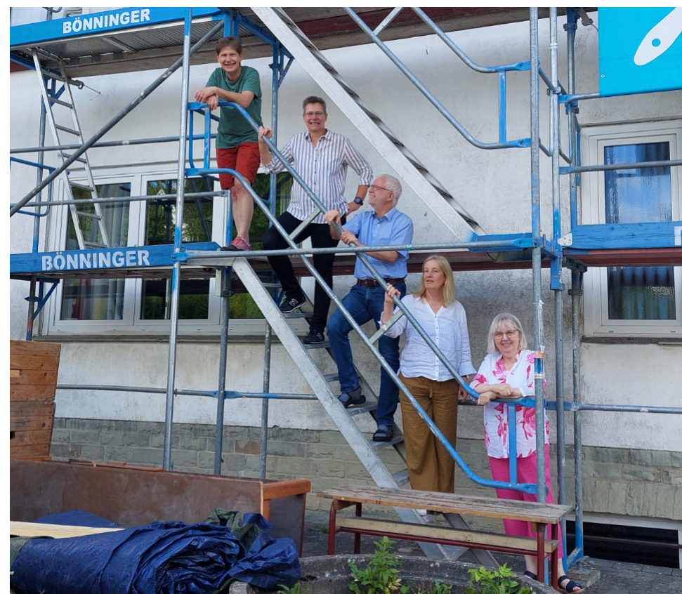
Auf der Baustelle
